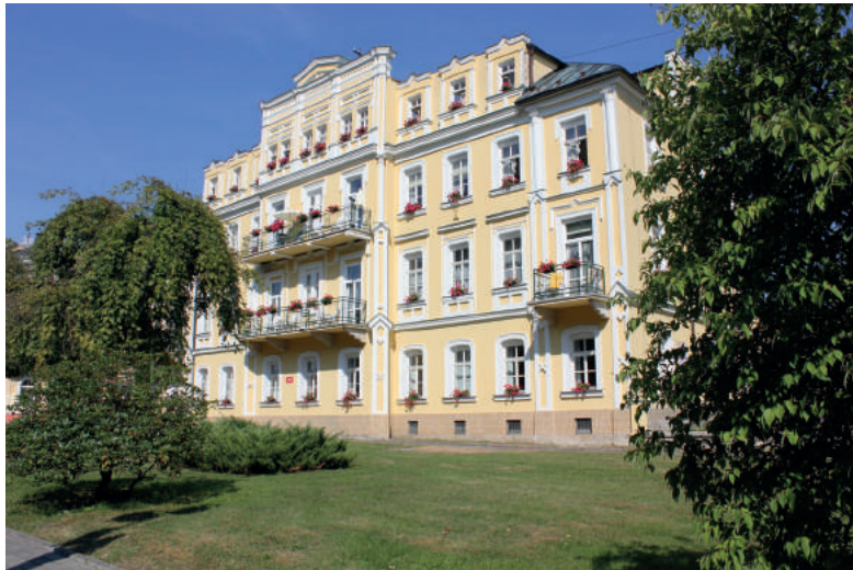
Realizace replik historických dřevěných oken lázeňského domu ve Františkových Lázní. Okna byla konzultována a schválena se zástupci Národního památkového ústavu – Oddělení památkové péče v Lokti.
